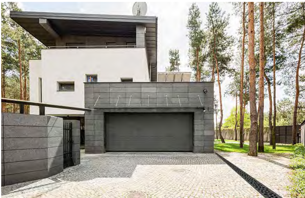
Grille Voronoï couleur Diamant installée près de l'accès au garage.
