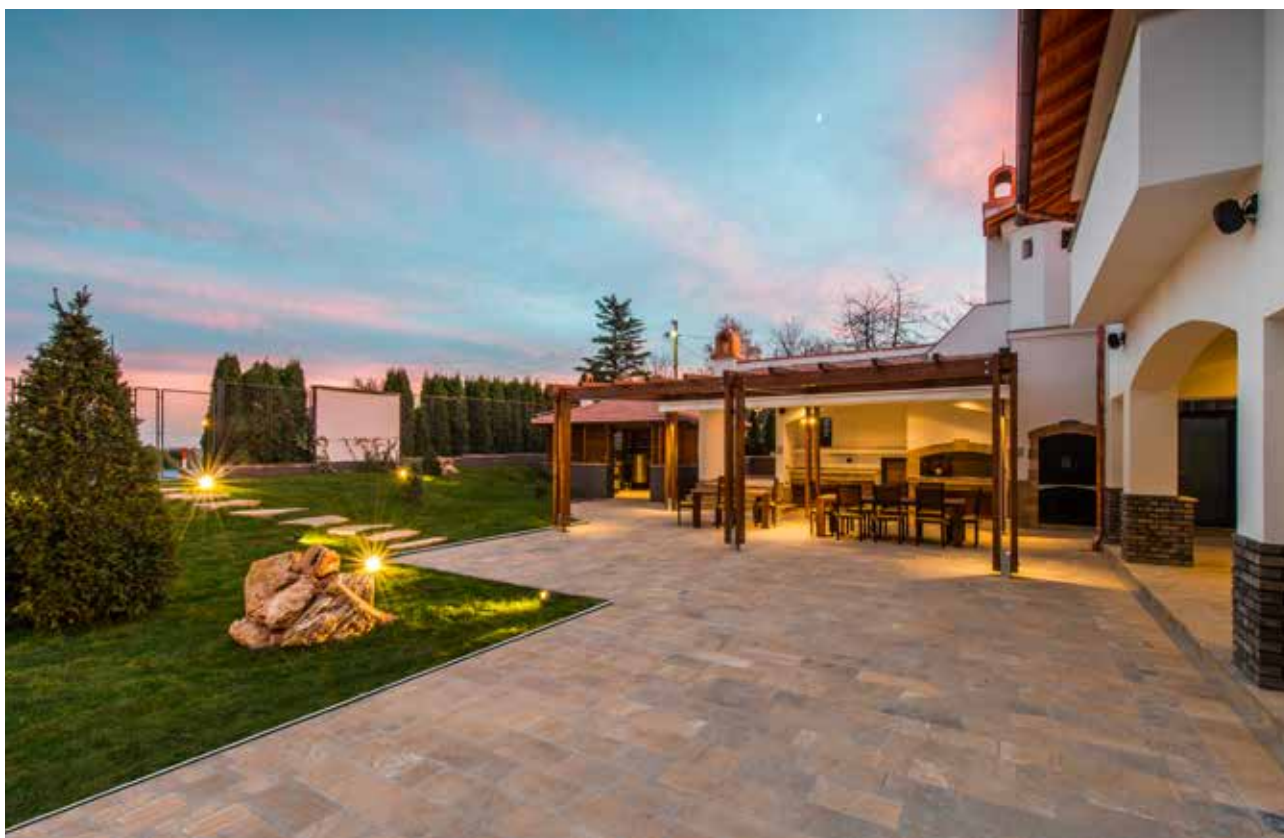
Couverture à fente installée en harmonie entre la terrasse et la pelouse.
