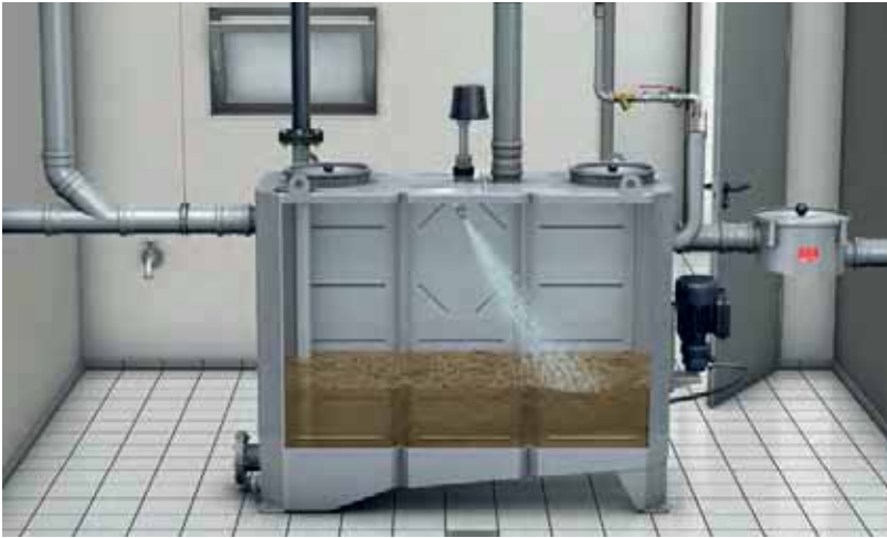
Nettoyage interne à haute pression des séparateurs de graisses, ne laissant aucun résidu
