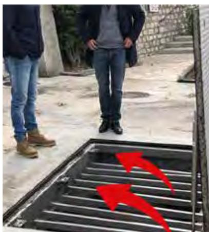
Relever le nombre de barreaux nécessaire (passage d'une pompe par exemple)
