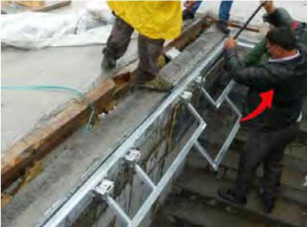
Lorsqu'un opérateur se trouve sous la trappe, le système permet de libérer instantanément toutes les vis de verrouillage en même temps en tirant simplement sur la poignée (flèche rouge).
