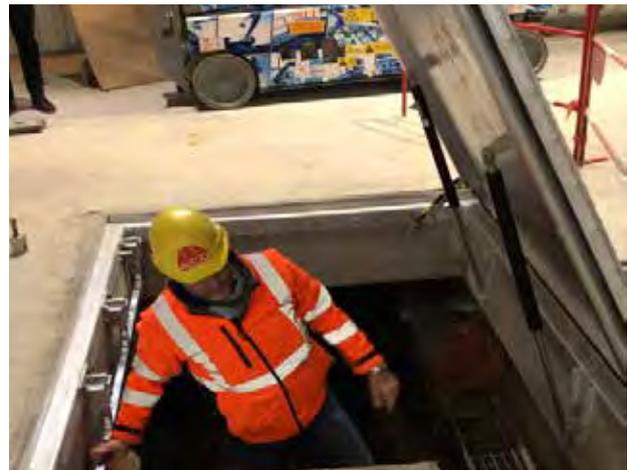
Remettre le bras de déverrouillage d'urgence en position initiale et refermer la trappe normalement.
