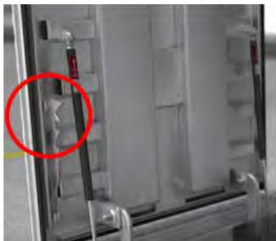
Un crochet fixé sous le couvercle permet de verrouiller le bras de sécurité.
