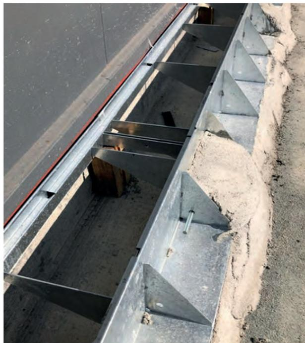
ACO Inspectline permet une imperméabilisation appropriée, un raccord étanche mur/sol de toutes les zones humides, et évite tout risque de fuite d'eau dans les cadres, pouvant causer des dommages futurs à la structure.
