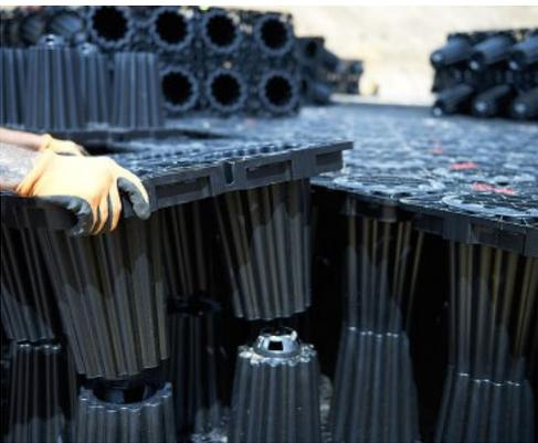
Les demi-modules mâles et femelles s'enclenchent avec un clic audible au moment de l'assemblage.
