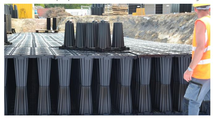
L'ensemble immobilier étant de grande ampleur en termes de surfaces collectées (plus de 3 hectares) et les espaces entre les lots n'étant pas assez conséquents, il a donc fallu opter pour la pose de 3 bassins de rétention et d'infiltration, constitués d'immenses structures réservoirs enterrées. Une alternative ingénieuse qui permit de s'adapter à la configuration du site et de conserver une exploitation totale du foncier en vue de réaménager la parcelle en espaces verts.
