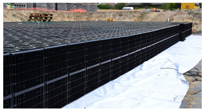
La grande légèreté du système **ACO Stormbrixx SD** (9.5 kg pour un demi module) et son assemblage facile ont contribué à une mise en œuvre rapide autorisant des cadences soutenues et réduisant d'autant plus la gêne des usagers pendant les travaux.
