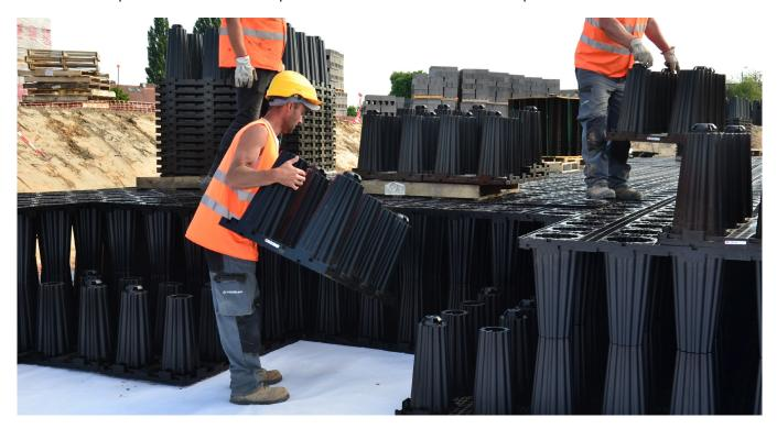
Fonctionnelle et performante, la Structure Alvéolaire Ultra Légère ACO Stormbrixx SD pour bassin de stockage enterré a permis au quartier Natura Verde, non seulement de désengorger ses réseaux en régulant les zones d'infiltration d'eau mais aussi de réduire les coûts d'évacuation des eaux pluviales, pour le bénéfice de tous!
