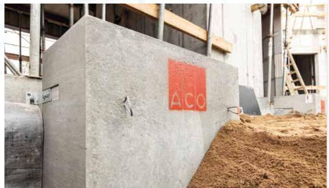
Puits de lumière combiné en béton avec et sans fond
