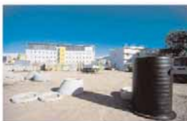
Livraison sur chantier.
