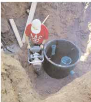
Remplissage de la fosse.
