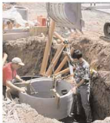
Mise en place du dispositif de couronnement en béton.
