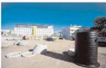
Livraison sur chantier.
