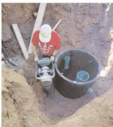
Remplissage de la fosse.
