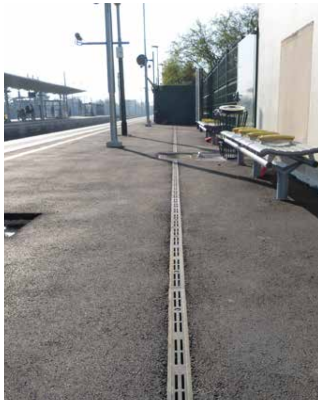
146 ml de caniveaux ACO Qmax 350 avec couverture en Fonte de 2x8 mm et 26 ml de caniveaux ACO Qmax 900 avec couverture en Fonte de 2x8 mm, classe de résistance F900
