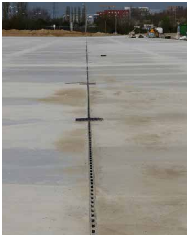
1462 ml de caniveaux ACO Qmax 225 avec couverture en Fonte de 26 mm, classe de résistance F900
