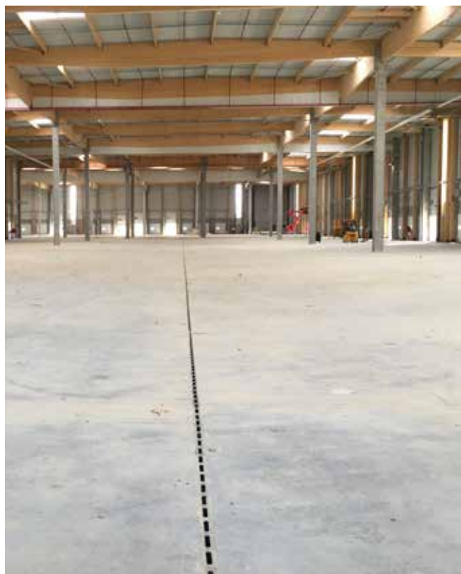
1462 ml de caniveaux ACO Qmax 225 avec couverture en Fonte de 26 mm, classe de résistance F900
