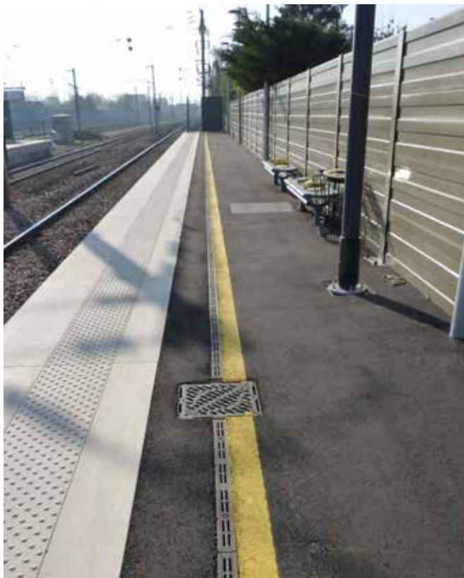
146 ml de caniveaux ACO Qmax 350 avec couverture en Fonte de 2x8 mm et 26 ml de caniveaux ACO Qmax 900 avec couverture en Fonte de 2x8 mm, classe de résistance F900
