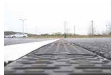
Les surfaces finies doivent être réalisées en prenant les précautions suivantes : la surface de roulement doit être surélevée de 3 à 5 mm par rapport à la surface du caniveau.
