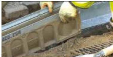
En partant de l'exutoire du réseau, connecter les caniveaux en suivant le sens de la flèche d'écoulement des fluides. L'emboîtement de deux caniveaux se fait par un jeu de formes mâle/femelle. Pendant la phase d'installation, il faut veiller à ce que le béton ne vienne pas gêner le montage.
