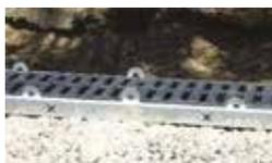
Durant la phase de coulée du béton, veiller à lester le caniveau à l'aide de barres de fer ou autres matériaux afin de stabiliser le caniveau. La grille doit être installée pendant la phase de coulée. Elle peut être remplacée par une planche de contreplaqué aux dimensions du caniveau et d'épaisseur 20 mm.
