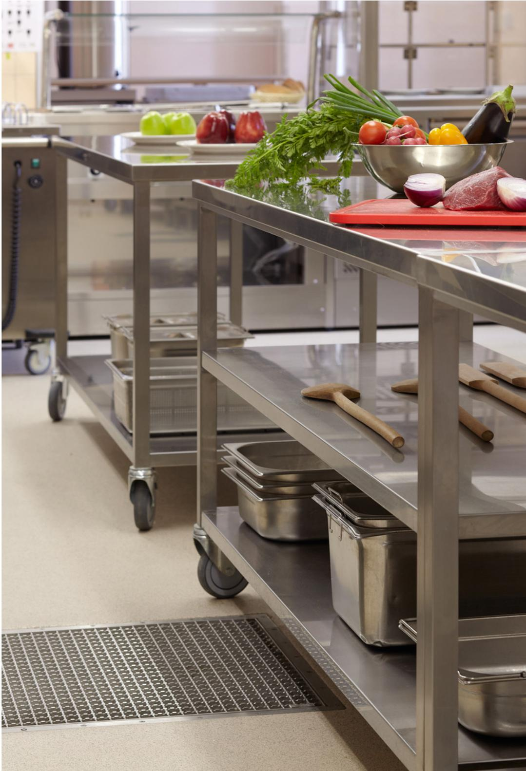
ACO Modul est une solution de drainage modulaire qui permet de proposer à partir de composants standards, des configurations à l'infinie. Elle se compose de caniveaux standards mais aussi de caniveaux sur-mesure pour répondre à des besoins d'implantations spécifiques.
