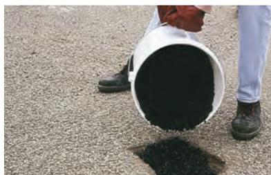
Verser dans le trou une quantité suffisante de Duroroute en créant un léger dôme recouvrant les bords.
