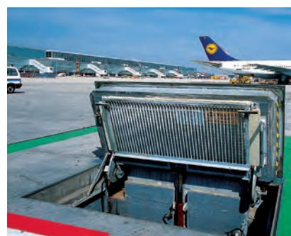
Tampon de visite permettant l'accès aux réseaux techniques sous la piste d'un aéroport
